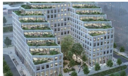
스칸스카 힐리에 테라스(기후중립건물) ©City of Malmö
