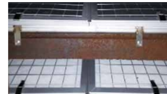
아산공장 도장 데드너 부스 2단 필터 설치
