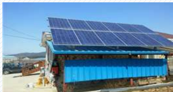
• 하드웨어 설치 (태양광)
