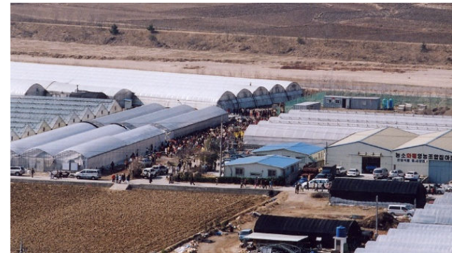
<공사장 진입로 점거 공사방해>
