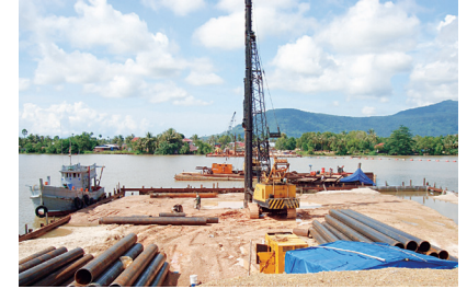
캄보디아 캄포트-트라판포포 도로 개보수사업 (2002. 10. 19)
