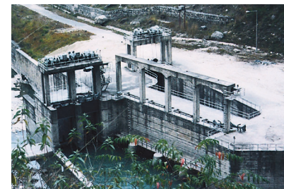
네팔 모디강 수력발전소 건설사업(1996. 10. 18)
