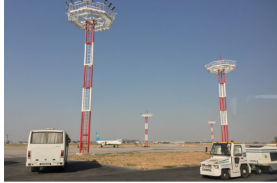
우즈베키스탄 타슈켄트 국제공항 건설사업 현장
