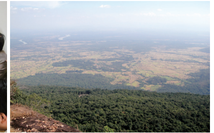
라오스 세피안-세남노이 수력발전소 부지 전경
