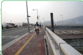
2 광진교 진입 후 우측 한강자전거 도로 경사로 이용
