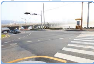
2 횡단보도 횡단 후 자전거도로로 진입
