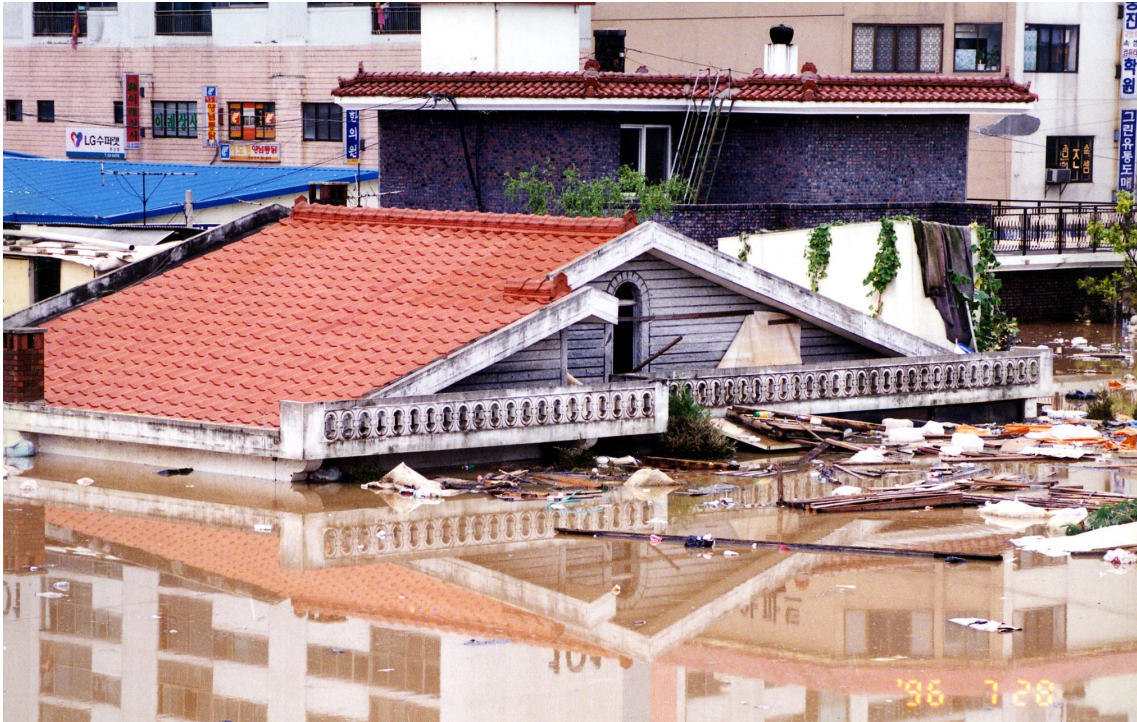
. 홍수피해 사진(1996년 문산읍 침수 전경)
