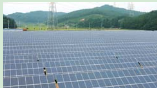
태양광 발전시설 (LG 태안 태양광 발전소)
