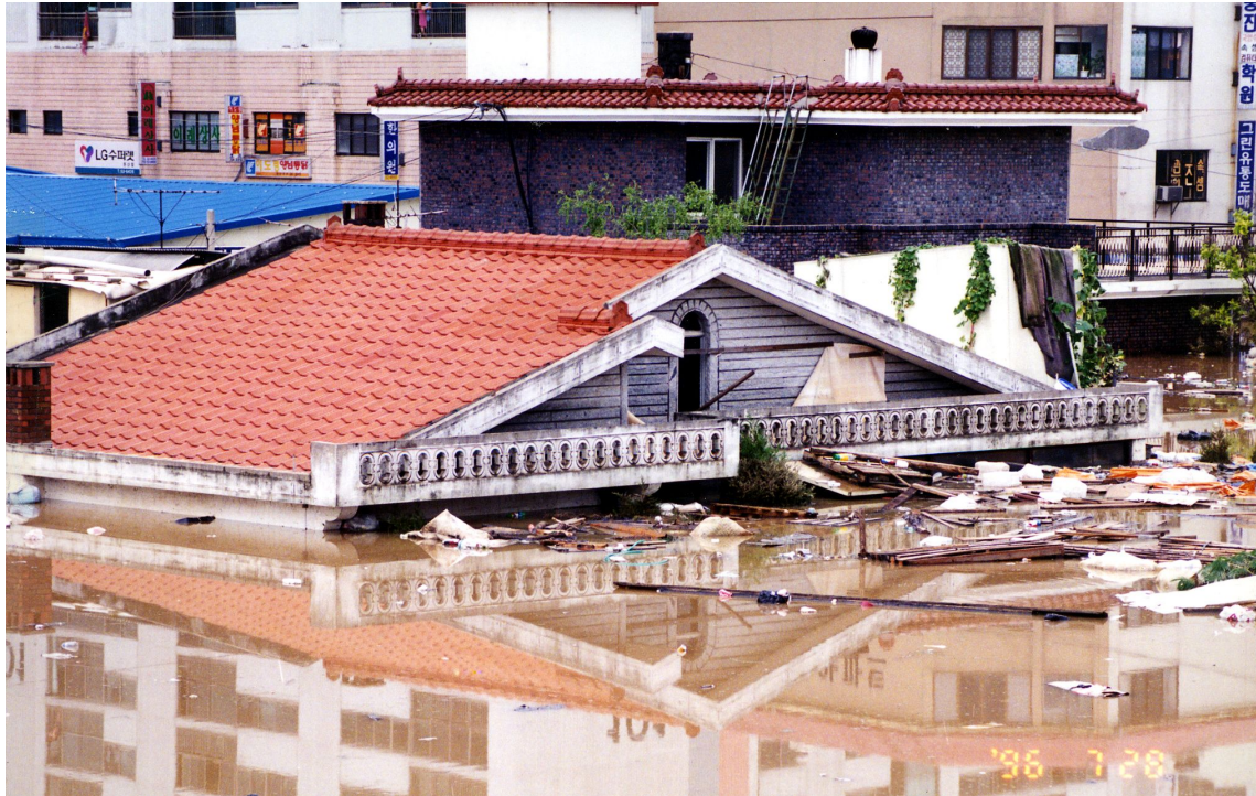
· 홍수피해 사진(1996년 문산읍 침수 전경)
