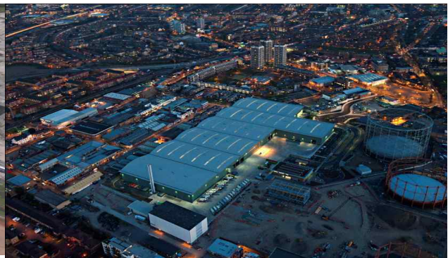
Veolia Southwark 통합 폐기물 처리 시설 (MBT, MRF 시설 포함)
