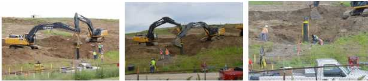
Bridgeton 매립지 포집 웅덩이 설치 현장
