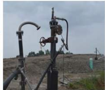
Bridgeton 매립지 매립가스 인터셉터 포집정과 온도 모니터링 전극
