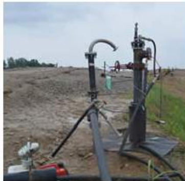
Bridgeton 매립지 매립가스 인터셉터 포집정과 온도 모니터링 전극
