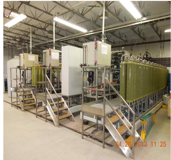
3단계 RO 시설 설치 현장 1)
