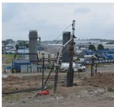
Bridgeton 매립지 매립가스 인터셉터 포집정과 온도 모니터링 전극
