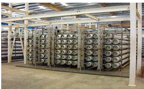
UF 멤브레인(304,640 m 2 , 68 skids)으로 용존고형물, 박테리아, 바이러스 제거하여 음용수 수질 물 생산 17)
