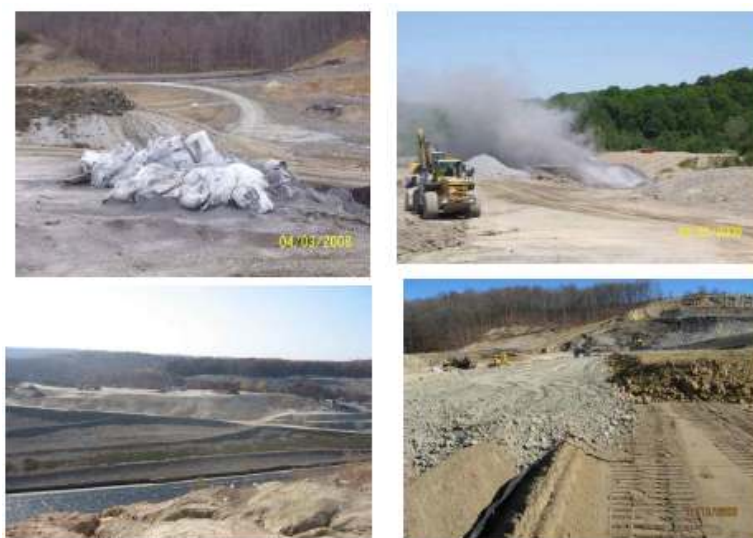
Athens Hocking 매립지 화재 발생 및 열벽체 설치
