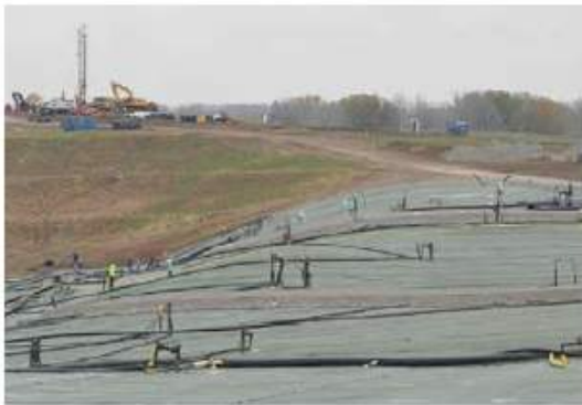
Bridgeton 매립지 온도 모니터링 전극 설치 현장
