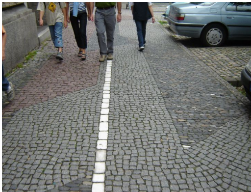
보행자도로에 설치된 노면표시
