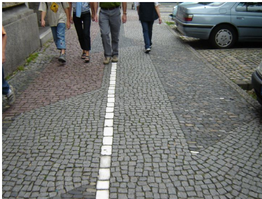
보행자도로에 설치된 노면표시
