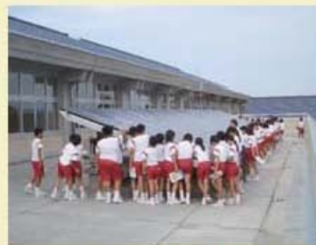
校舎屋上に太陽光発電パネルを設置
