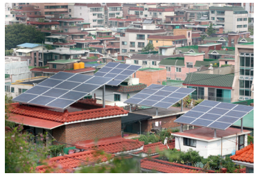
주택 태양광 설치
